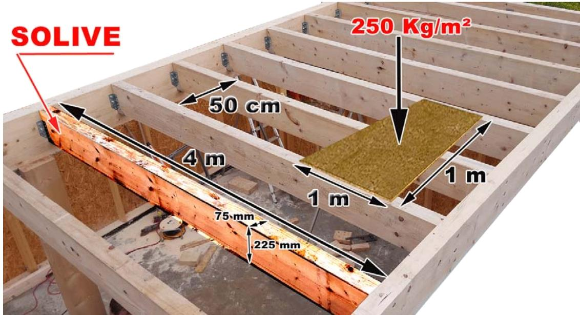
**1/ Flèche autorisé par la norme** : 1/400 de la longueur pour les ouvrages fléchis, autres que les consoles, supportant une circulation régulière ou un remplissage
